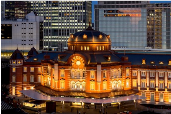
ホテルが位置する東京駅丸の内駅舎
